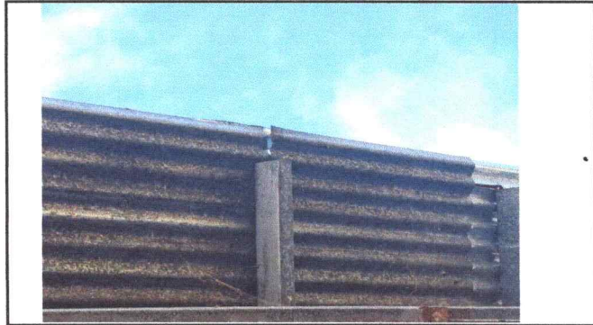
Foto 2 se puede observar que las láminas se encuentran rajadas.
